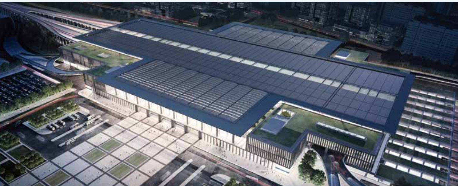
■ 工程监理 北京丰台站 北京市重点工程之一, 亚洲最大铁路交通枢纽, 国内首座双层车场设计的大型车站, 首都北京新的迎宾门和新地标获得第十五届“中国钢结构金奖”
