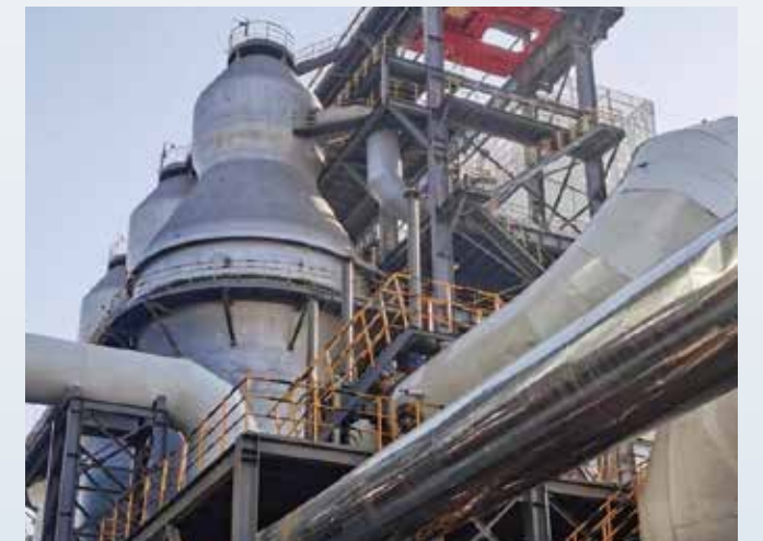
热风炉 天津荣程5号高炉大修工程热风炉 热风炉送风温度≥1250℃ 吨铁高炉煤气耗量~450Nm 3 /t 烟气中NO x 平均排放浓度~20mg/m 3
