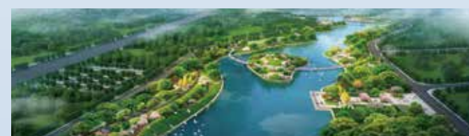
■ 河道综合治理 呼和浩特市扎达盖河综合治理工程 河道治理长度5km
