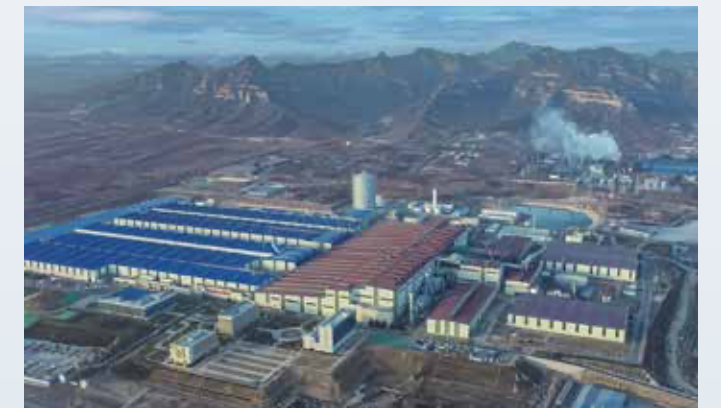
河钢集团石钢环保搬迁升级改造项目 世界最先进的绿色、智能、高效短流程特钢示范项目
