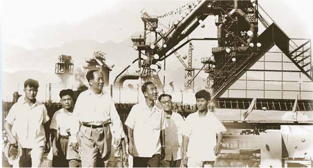
■ 毛泽东视察公司参加设计的大冶钢厂工地
