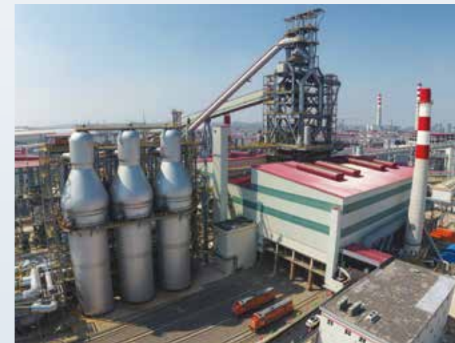
热风炉 河钢产业升级及宣钢产能转移项目热风炉 采用四段式顶燃热风炉结构 减轻热风出口组合砖荷载, 延长使用寿命 荣获国家优质工程金奖和全国冶金建设行业工程设计优秀成果一等奖
