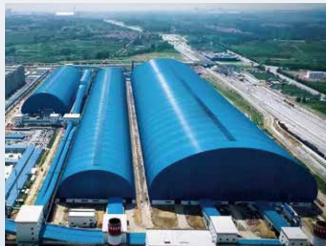
环保料场 临沂钢投特钢年产270万吨优特钢项目智能化原料场工程 国内跨度最大的螺栓球网架结构的全封闭料场 荣获中国冶金建设协会、山东省和临沂市优质结构工程奖
