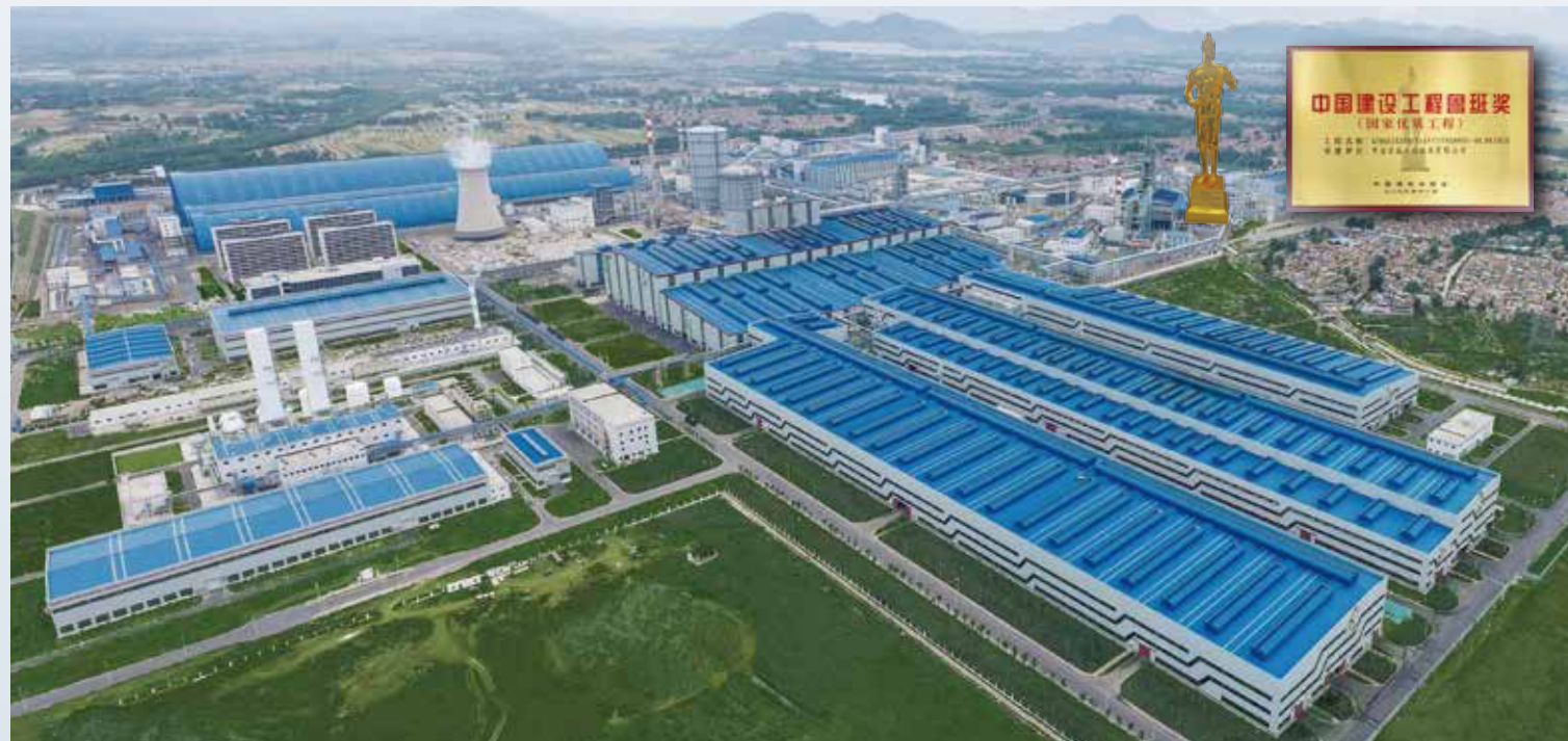
临沂钢投特钢年产270万吨优特钢项目 我国优特钢领域首次全工序、一次性贯穿建成的最大规模冶金长流程项目
