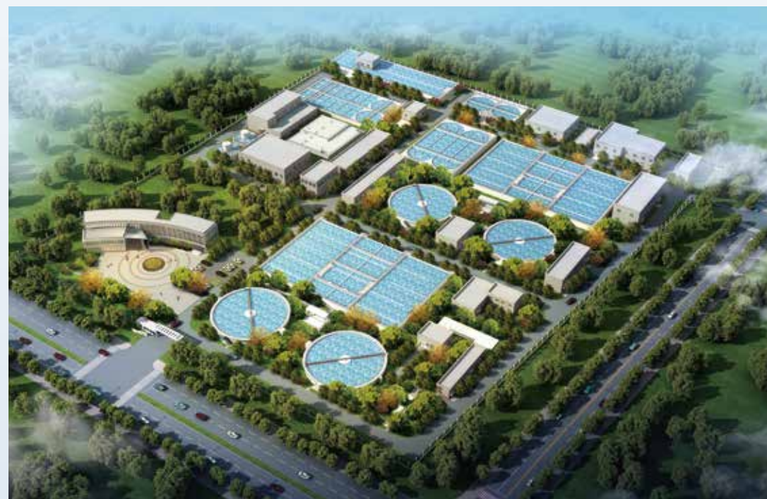
■ 污水处理及污泥处理处置 固安AMOLED污水处理厂 总处理规模60000m 3 /d, 其中生活污水30000m 3 /d, 工业废水30000m 3 /d
