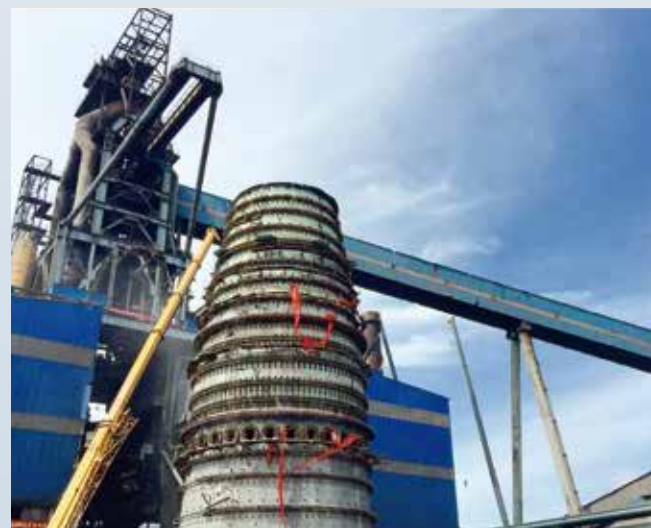
高炉 沧州中铁2350m 3 高炉大修项目 国内最大高度、最大吨位的高炉整体推移快速大修工程 工期较传统高炉大修工程缩短50%以上 荣获全国冶金建设行业工程设计优秀成果一等奖
