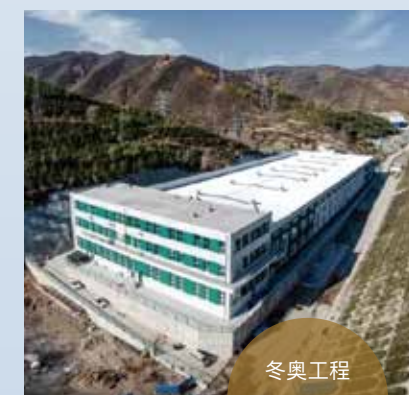
■ 绿色供热 张家口崇礼城区热源厂煤改电项目 世界首例采用110kV 高压蓄热式锅炉的热源厂
