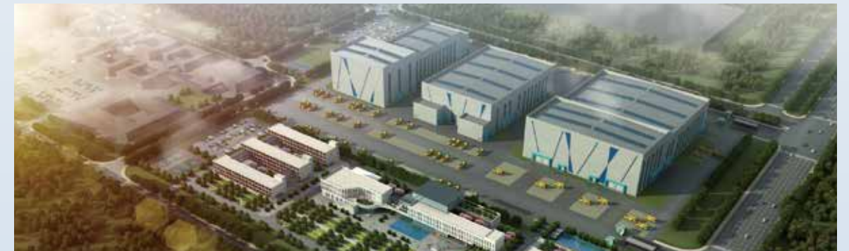
■ 清洁低碳能源 雄安新区容西1号混凝土搅拌站在单站产能、质量管控、绿色环保、智慧运维方面国内领先
