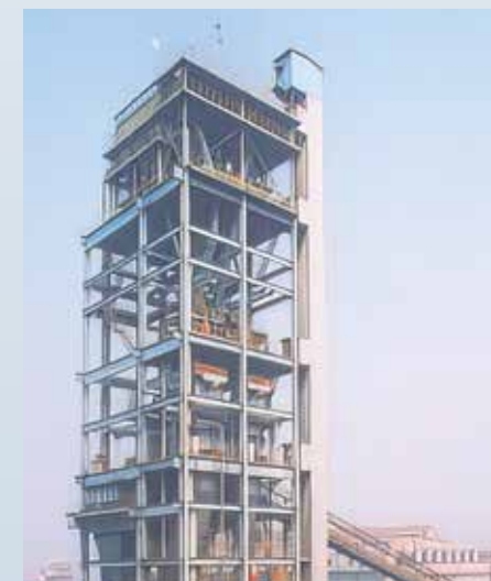
低碳冶炼 宝钢3号高炉(4350m 3 )富氧大喷煤工程 国内自动化程度最高, 规模最大的喷煤工程 荣获全国第八届优秀工程设计金质奖
