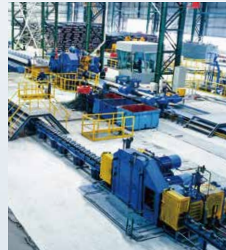
棒材 山西晋城福盛钢铁棒材项目 国际首创单一孔型高速棒材轧制技术 创造了Ø12mm螺纹钢稳定运行速度达45m/s的世界纪录
