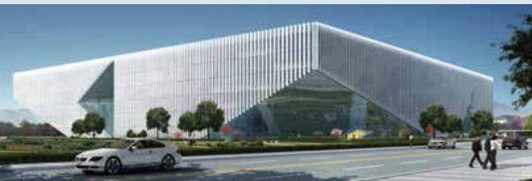
■ 工程监理 腾讯北京总部大楼 北京中关村软件园标志性建筑 国内最大悬挑81米的建筑物 是腾讯科技有限公司在北京网媒接待的重要门户和腾讯公司国际形象的代表 获得中国土木工程詹天佑奖 中国建设工程鲁班奖 国家优质工程
