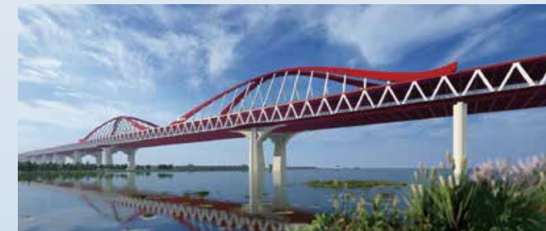
■ 工程监理 西安地铁十号线 陕西西安境内的一条建设中的地铁线路, 线路大致呈南北走向 建成后将成为连接主城区与渭河北岸的轨道交通快线 对优化城市总体空间布局、实现北跨渭河发展战略推动区域融合、促进沿线产业升级具有十分重要的意义
