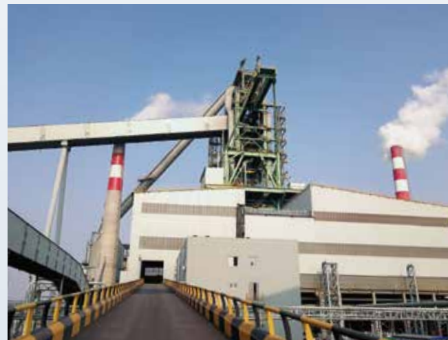
高炉 河北纵横集团丰南钢铁有限公司高炉工程 应用多项绿色、低碳、高效技术, 寿命超过15年 基于新一代工业互联网平台打造智能制造系统
